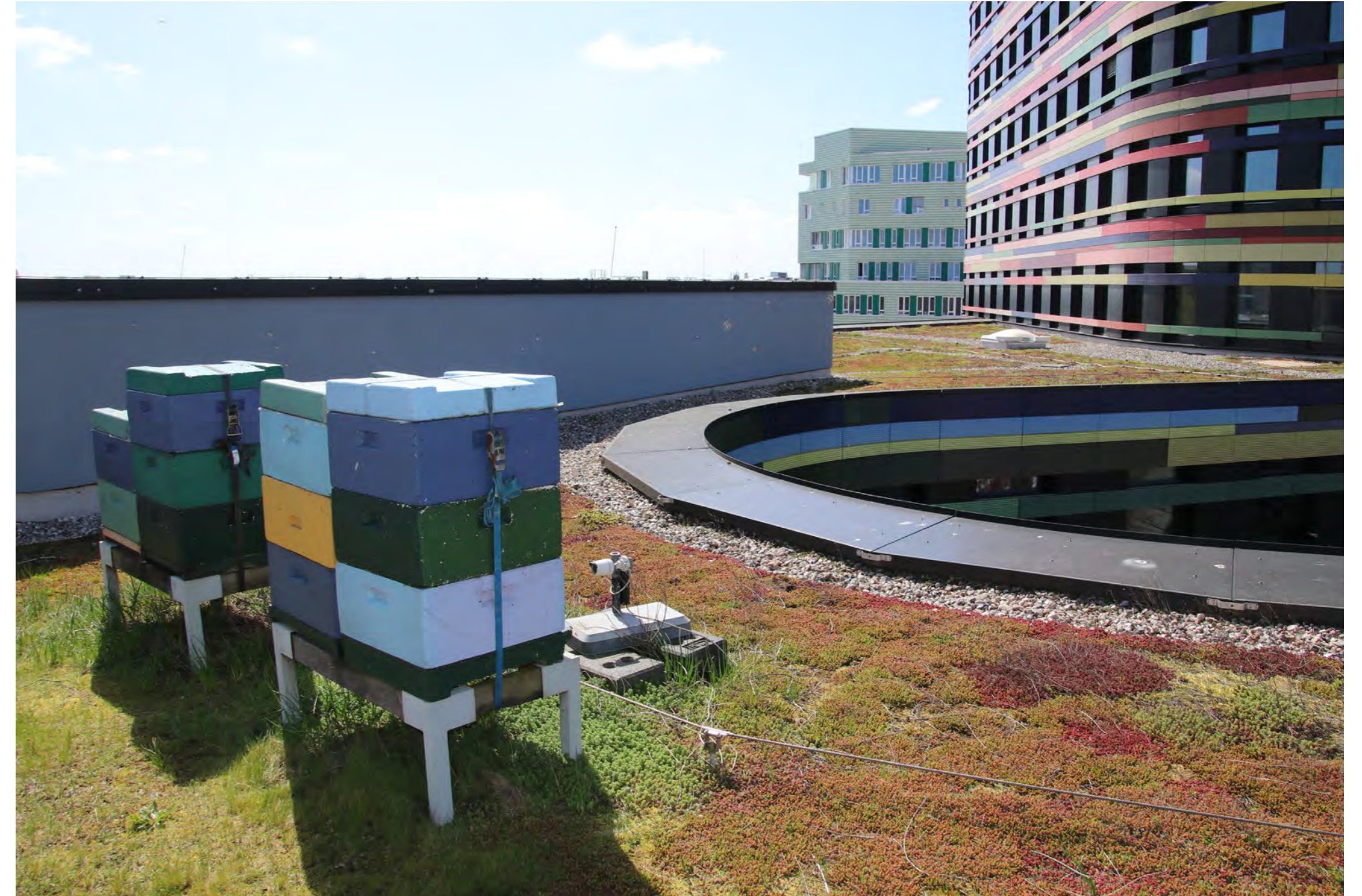
Dach der Behörde in Wilhelmsburg, Foto © BUKEA, Jan Pastoors
